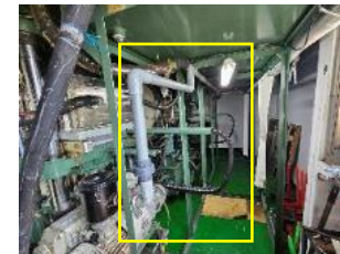
施工後機台串聯
