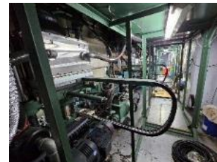
施工前機台獨立
